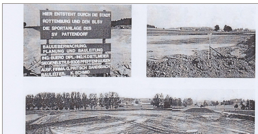
Die Stadt Rottenburg gab grünes Licht für das Bauprojekt des Sportplatzes „An der Schleifmühle“, daraufhin konnte man am 4. Juli 1988 mit den Erdschussarbeiten beginnen.
